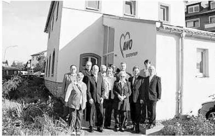
Das AWO-Haus am Winterleitenweg in Höchberg wurde gründlich saniert und in „Haus der Senioren und Vereine“ umgetauft, weil jetzt im Obergeschoss auch Ortsvereine eine Bleibe gefunden haben. FOTO SIEDLER
